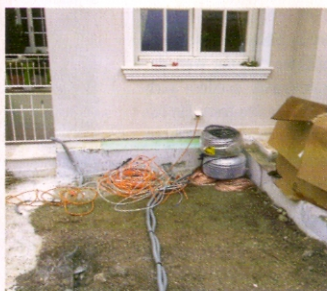
Die Kabel wurden in Plastikrohren quer durch den Garten gelegt.
